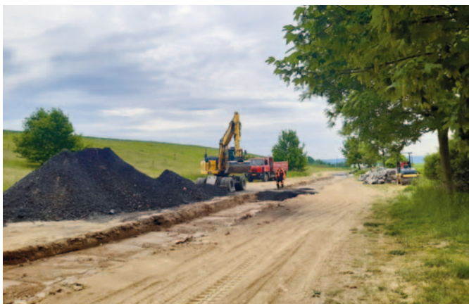
• Budování přístupové komunikace k rybníku.
